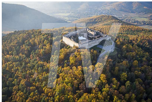
Château du Hohlandsbourg (3)
