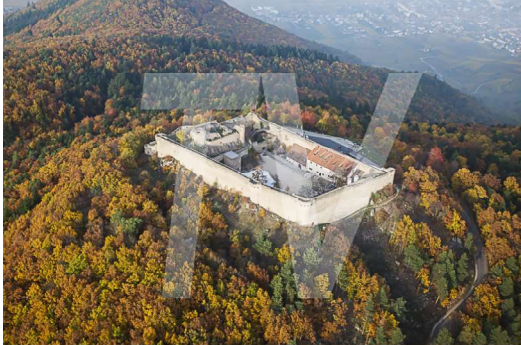
Château du Hohlandsbourg (1)
