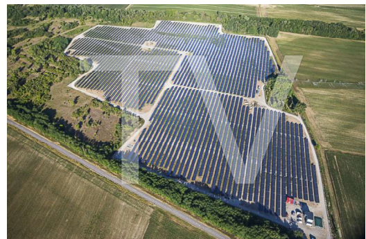
Centrale solaire photovoltaïque de Volgelsheim (4)
