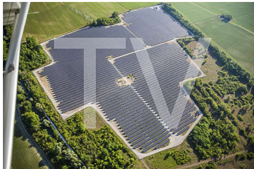
Centrale solaire photovoltaïque de Volgelsheim (1)
