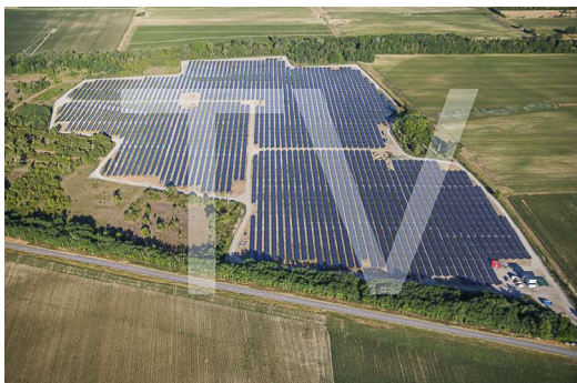
Centrale solaire photovoltaïque de Volgelsheim (3)
