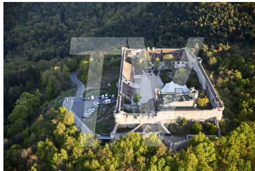
Château du Hohlandsbourg (5)
