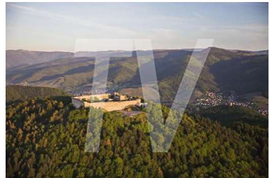
Château du Hohlandsbourg (2)
