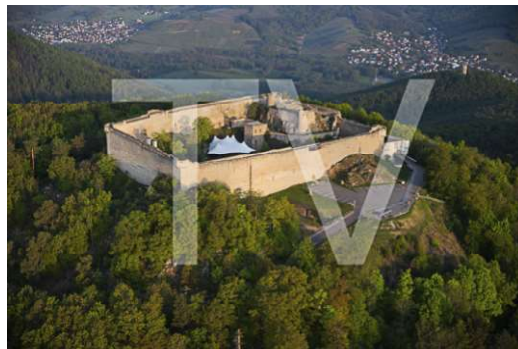
Château du Hohlandsbourg (10)
