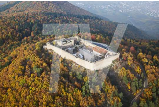
Château du Hohlandsbourg (1)
