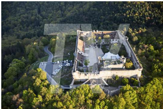
Château du Hohlandsbourg (4)
