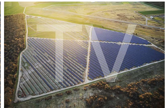
Centrale de Rixheim (1)
