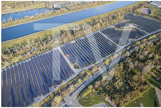
Centrale solaire Ottmarsheim (14)
