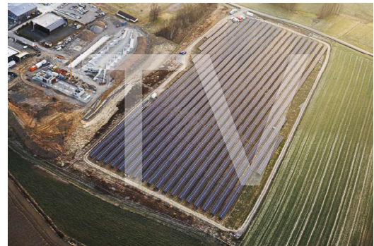
Centrale de Retzwiler (1)
