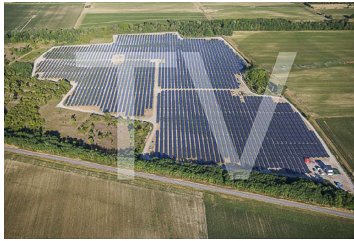
Centrale solaire photovoltaïque de Volgelsheim (3)
