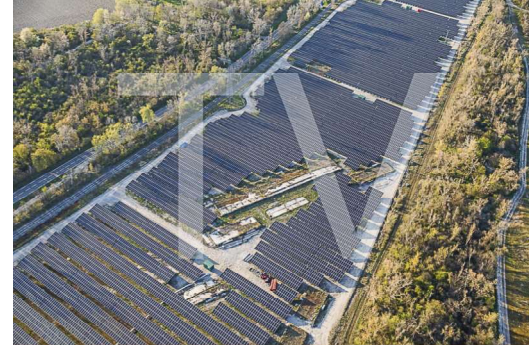
Centrale solaire Ottmarsheim (19)
