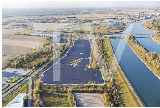
Centrale solaire Ottmarsheim (3)
