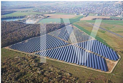
Centrale de Rixheim (13)
