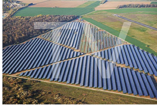
Centrale de Rixheim (12)
