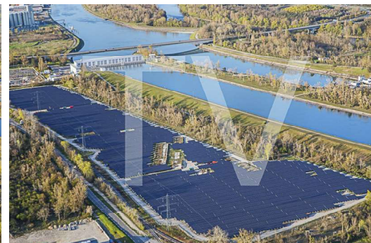
Centrale solaire Ottmarsheim (25)
