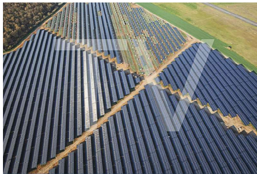
Centrale de Rixheim (24)
