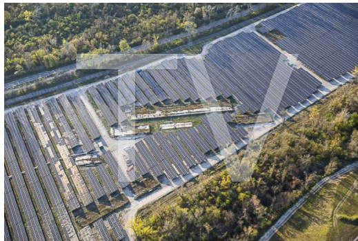
Centrale solaire Ottmarsheim (9)
