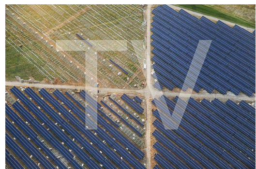
Centrale de Rixheim (8)
