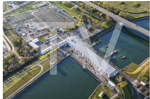
Centrale solaire Ottmarsheim (10)
