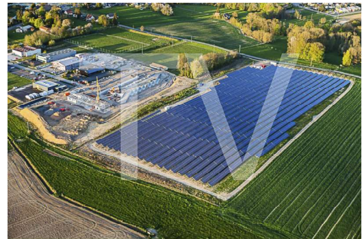
Centrale de Retzwiler (5)
