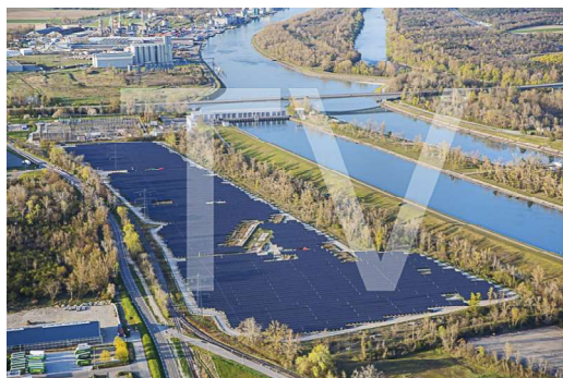
Centrale solaire Ottmarsheim (27)
