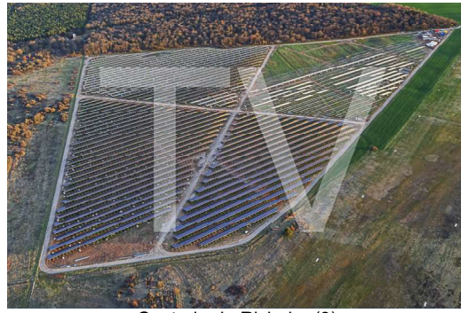
Centrale de Rixheim (3)
