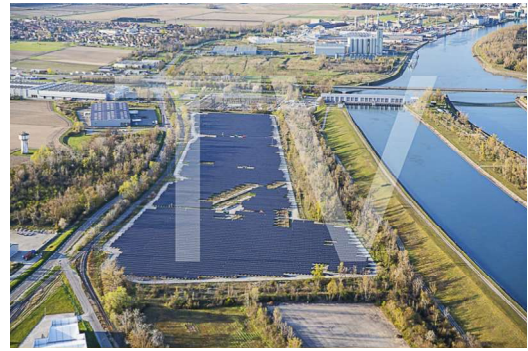
Centrale solaire Ottmarsheim (1)
