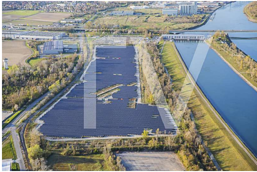
Centrale solaire Ottmarsheim (2)
