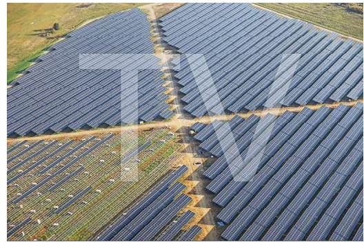
Centrale de Rixheim (23)
