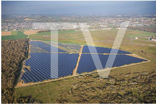
Centrale de Rixheim (19)
