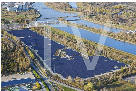
Centrale solaire Ottmarsheim (26)
