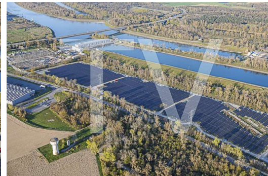
Centrale solaire Ottmarsheim (22)
