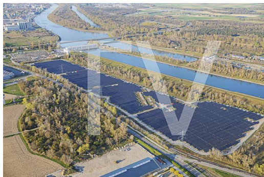
Centrale solaire Ottmarsheim (24)
