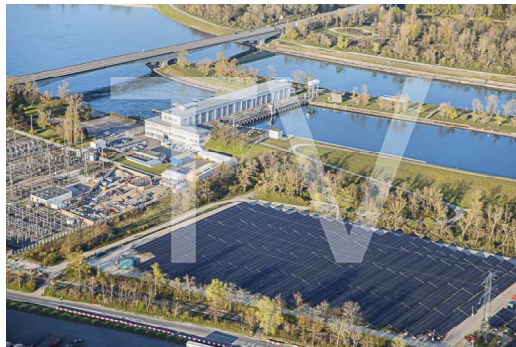
Centrale solaire Ottmarsheim (21)
