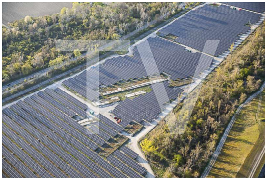
Centrale solaire Ottmarsheim (8)
