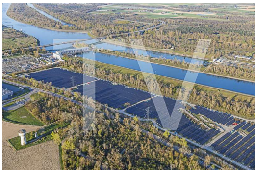
Centrale solaire Ottmarsheim (23)
