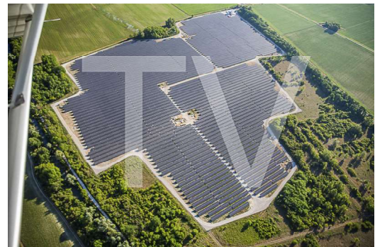
Centrale solaire photovoltaïque de Volgelsheim (1)
