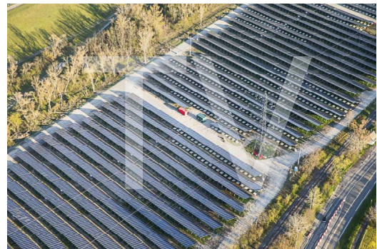
Centrale solaire Ottmarsheim (13)
