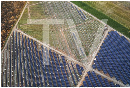
Centrale de Rixheim (10)
