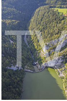
Barrage du Chatelot (3)
