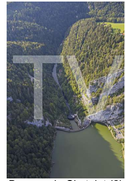
Barrage du Chatelot (2)
